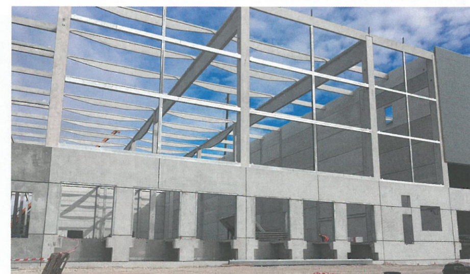
▲ Obr. 14 Prefa konstrukce
