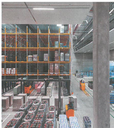
▲ Obr. 6 Pohled do regálového skladu
