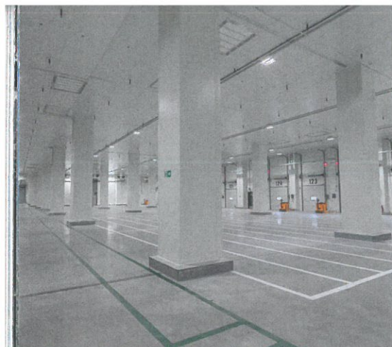
▲ Obr. 5 Pohled do chlazeného skladu
