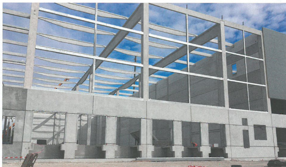
▲ Obr. 14 Prefa konstrukce
