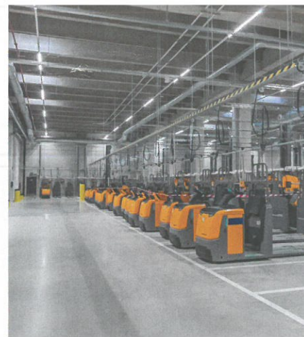
▲ Obr. 7 Pohled do nabíjecí stanice
